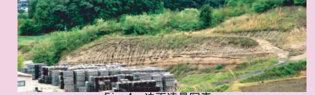
Fig. 4 法面遠景写真
