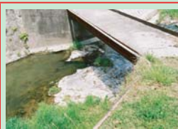
写真-4 河床に分布するユニット3
