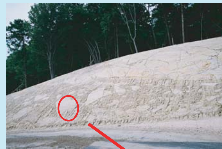
写真-8 含礫砂岩ブロックと破砕部の境界に凝灰岩が貫入
