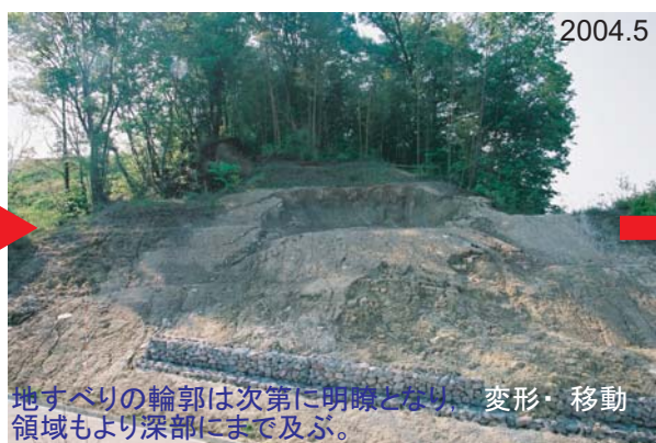
神戸層群で発生する小規模流動型地すべりは、きわめて狭い範囲で、明瞭なせん断面に沿って剛体が滑り落ちるというよりも、移動層全体が破壊され、流れできるように移動する地すべりである。
