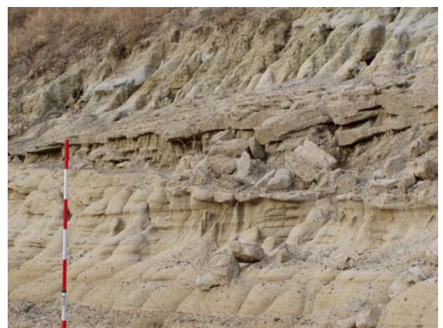
写真-3 軟質凝灰岩の削剥により上位層の砂岩がブロック状に崩壊している
