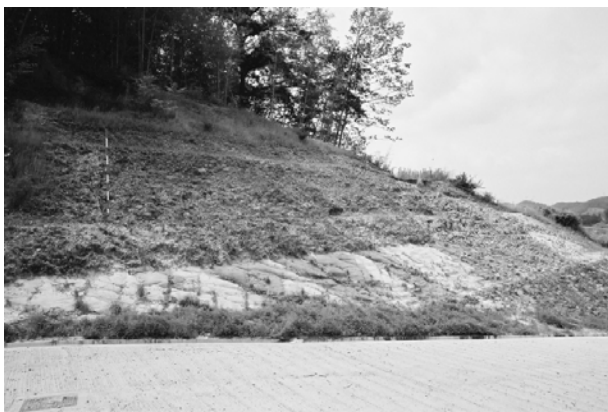
写真-1 奥山上池脇の切土斜面で発生した小規模流動型地すべりの全景写真(2003年11月撮影)
