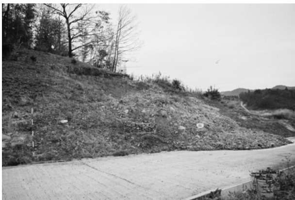
写真-2 奥山上池脇の切土斜面で発生した小規模流動型地すべりの全景写真(2004年12月撮影)
